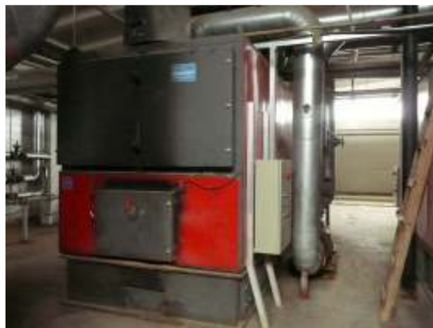
54. Tahkekütuse katlad, 2tk/ Boilers- Uniconfort CMT/F 300 3480 kw,
